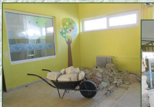
Stavební práce ve školce. Foto: Alena Kovaříková
