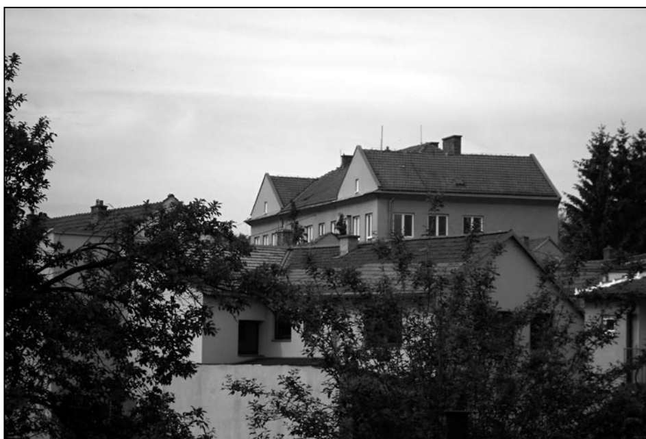
Pohled na současnou střechu základní školy. Foto: Alena Kovaříková
