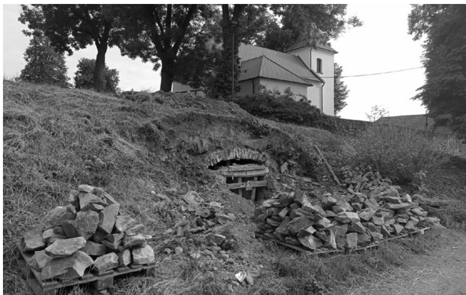
Ochozská chasa se pustila do rekonstrukce starého sklepa pod hřbitovem.
