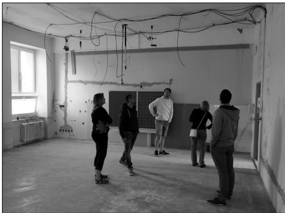
Rekonstrukce elektrorozvodů v 2. podlaží.
