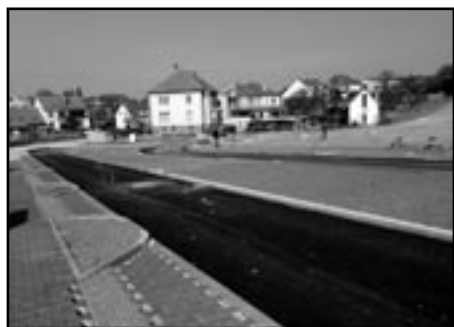
Pokračující výstavba Pod Skalkou.
