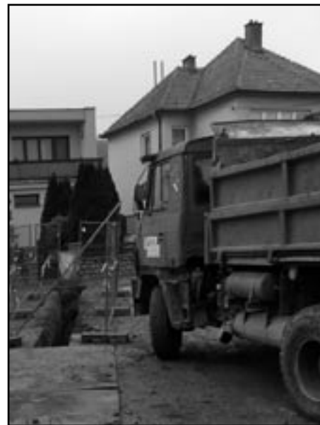
Oprava komunikace vedoucí okolo Svazarmu ke hřišti.
