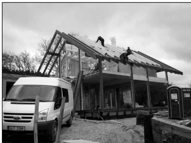
Dřevěný skelet domu.
