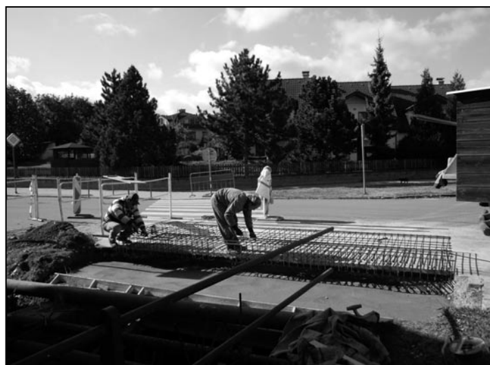
Oprava mostku na návsi.
