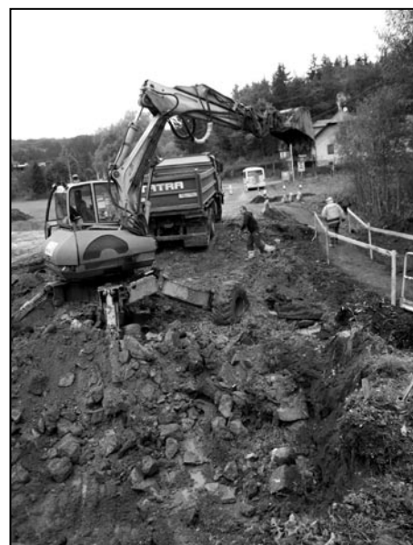
Práce na mostku Pod Hádkem.
