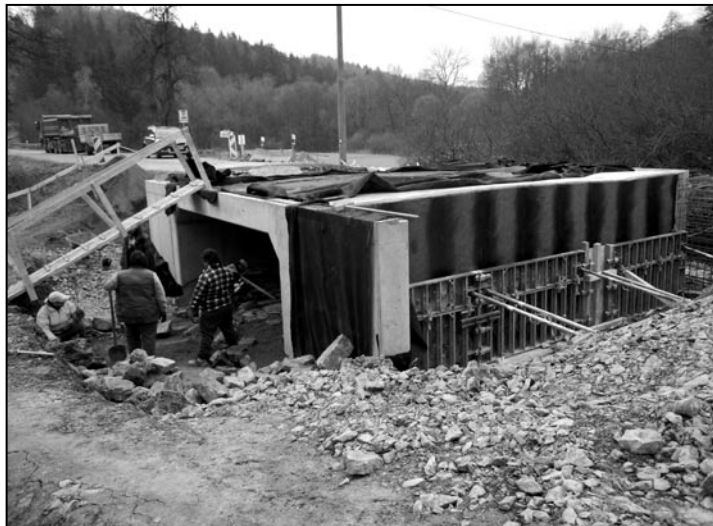
Práce na mostku Pod Hádskem.
