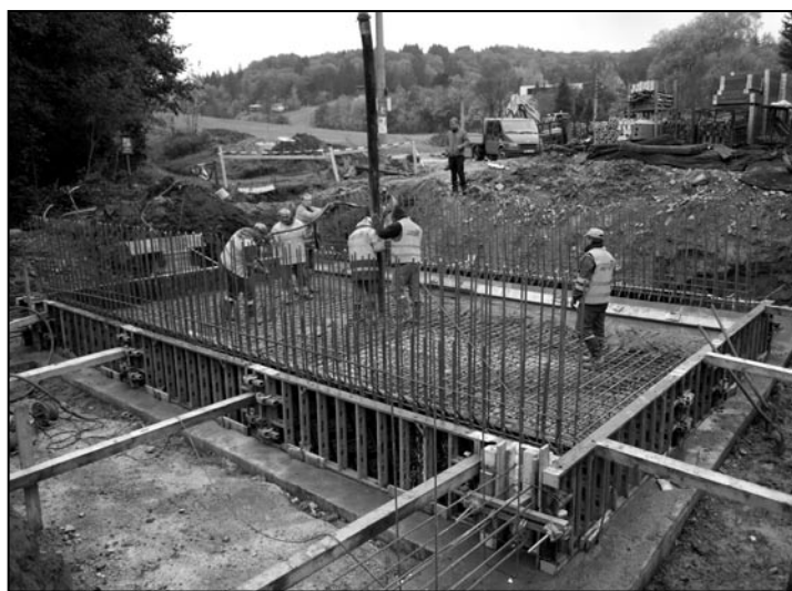
Práce na mostku Pod Hádskem.
