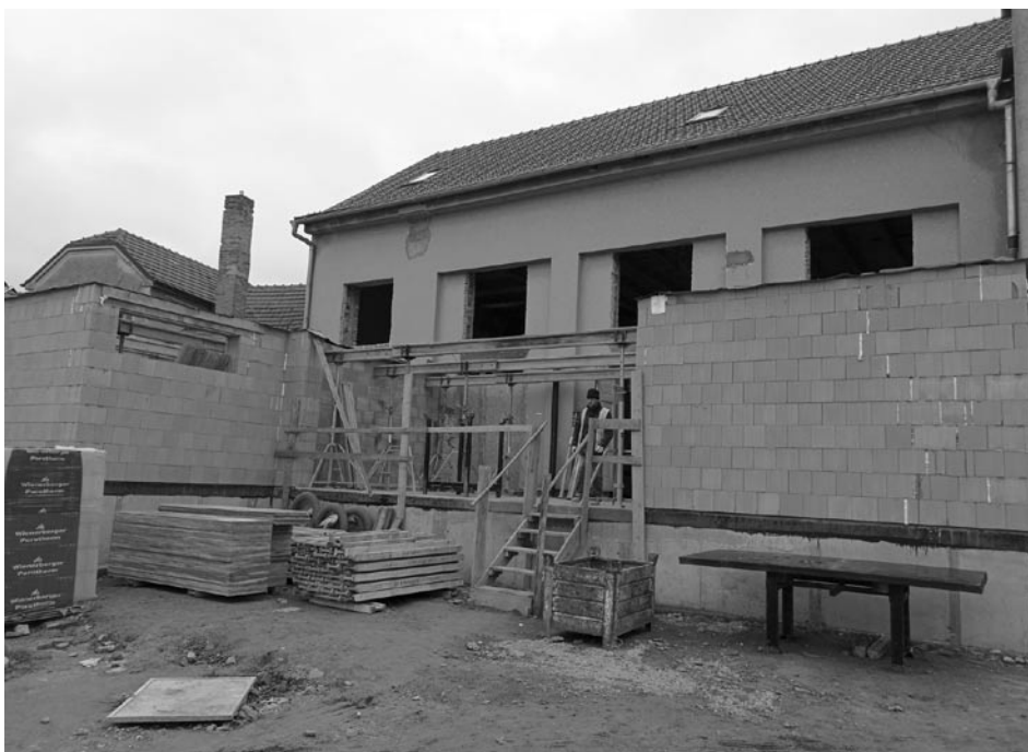
Stavba nářad'ovny a zadního vstupu do Sokolovny
