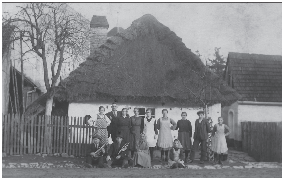
Domek s doškovou střechou u Rudynků na ochozské návsi, 20. léta 20. století
