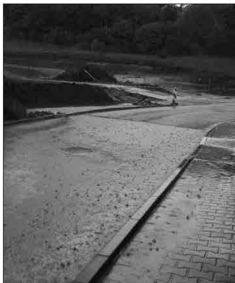
Místo plánovaného napojení komunikace z výstavby Pod Skalkou za deště
