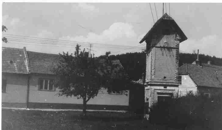
Trafo na Zákazanci.
