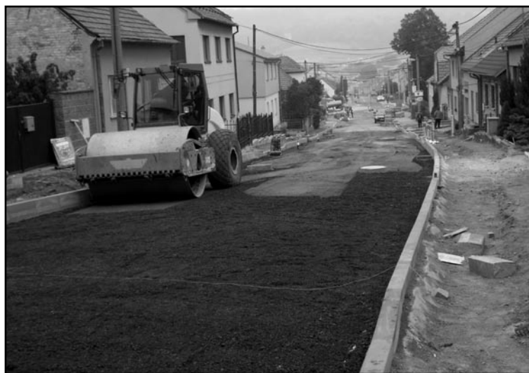
Horní část opravované silnice Na Pastýrkách v půlce října.
