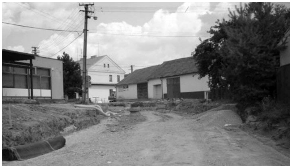
Záběr ze stavby silnice v roce 2006
