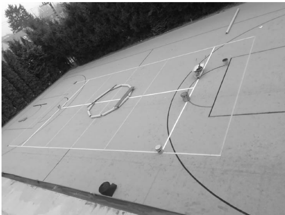
Dokončovací práce nového multifunkčního hřiště v areálu AVZO u Bistra
