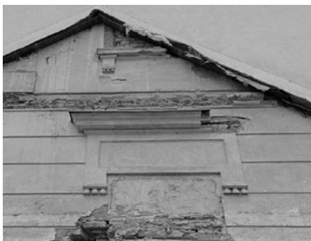
Na ZŠ se po odkrytí staré střechy přístavku objevila propracovanost původní fasády.
