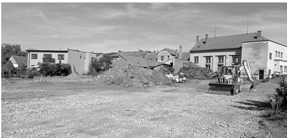
Začaly rekonstrukční práce kolem Sokolovny.
