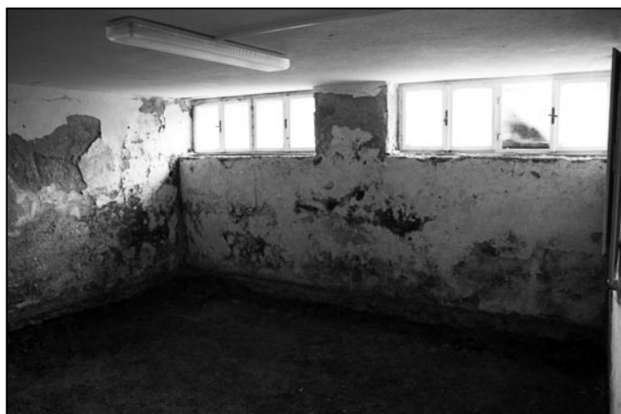
Přípravné práce na sokolovně.
