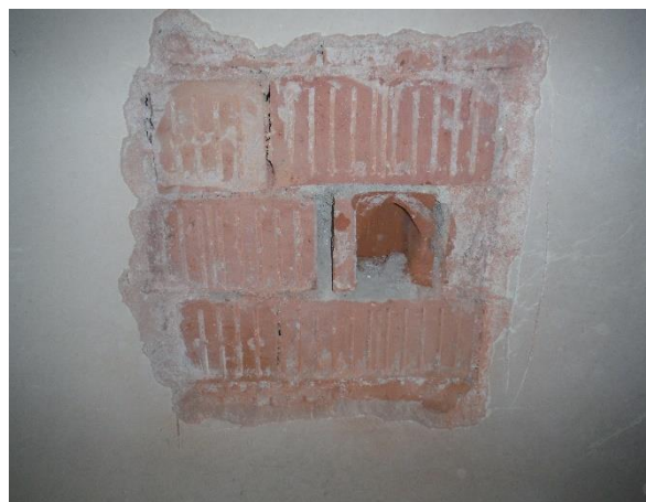
FOTO č. 3: Sonda A1 v 1NP v místnosti 103
