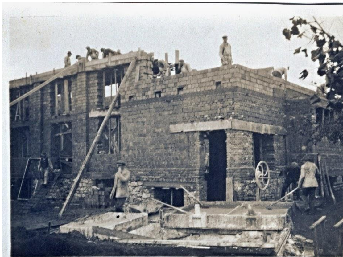
FOTO č. 1: Dobová fotografie z průběhu výstavby zachycující materiálovou skladbu zdiva
