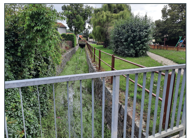
Zpevněné koryto Ochozského potoka vymezující plochy z východní části
