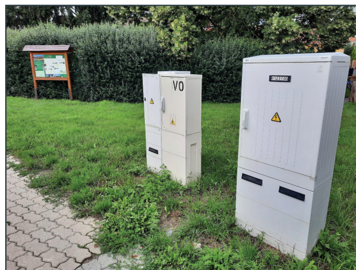
Sloupky inženýrských sítí u zastávky, v pozadí informační tabule
