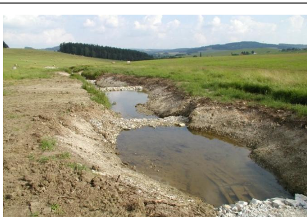
Soustava tůňových rozlín se sníženými sklony břehů stabilizovanými dnovými kamennými pasy.
