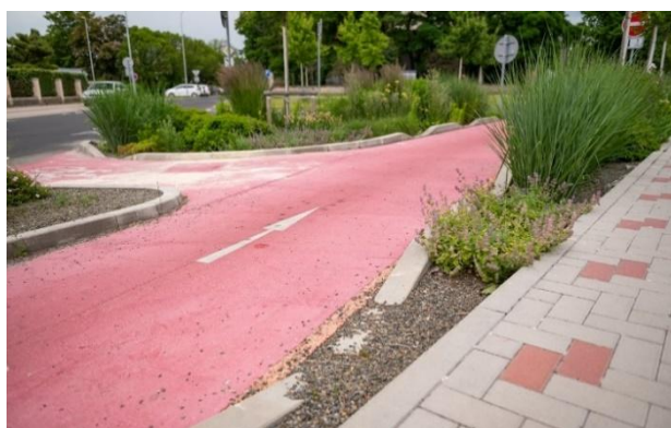
Realizace odtoku srážkové vody z komunikace (Roudnice nad Labem)
