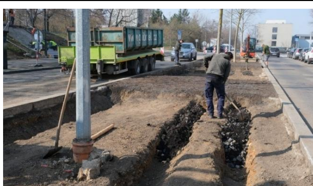
Kořenové cesty pro stromy vytvořené v rámci rekonstrukce zeleného pásu (ul. Kostelní, Praha).
