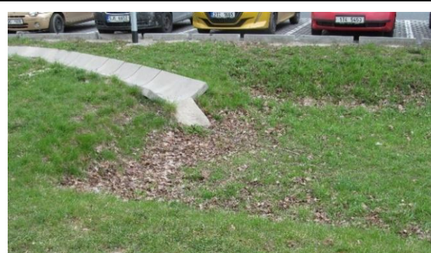
Zasakování dešťových srážek u objektu Petrin (Bruntál)
